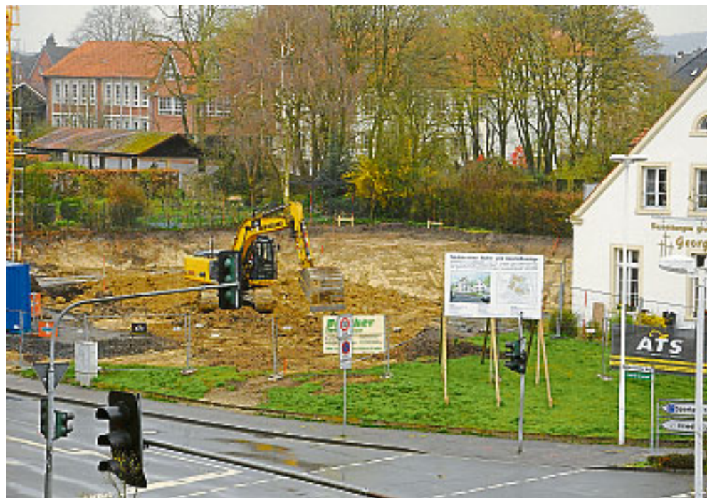
Baustelle Niederstockumer Weg 2: Die Ausschachtungsarbeiten für die Tiefgarage des Wohn- und Geschäftshausensembles sind in vollem Gange. Von den 13 neu entstehenden Eigentumswohnungen (Gesamtwohnfläche 939 Quadratmeter) sind bereits elf vermarktet. Foto: Ludger Warnke
