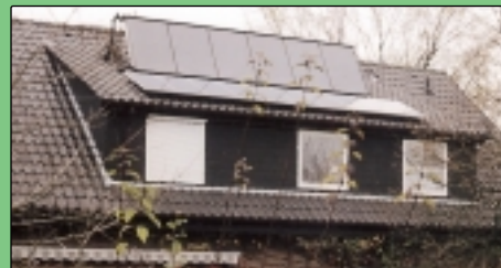
Solaranlage auf einem Nottulner Einfamilienhaus
